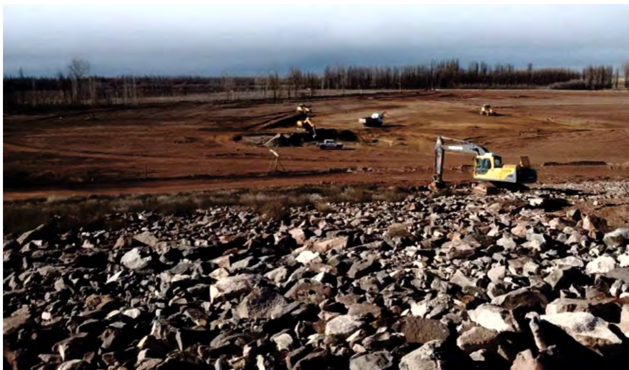
Preparación de base de trinchera. Fuente: diadelsur
